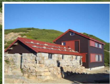
※将裨頭山(標高2730m)直下にある山小屋 築100年を迎える「石室」が健在
